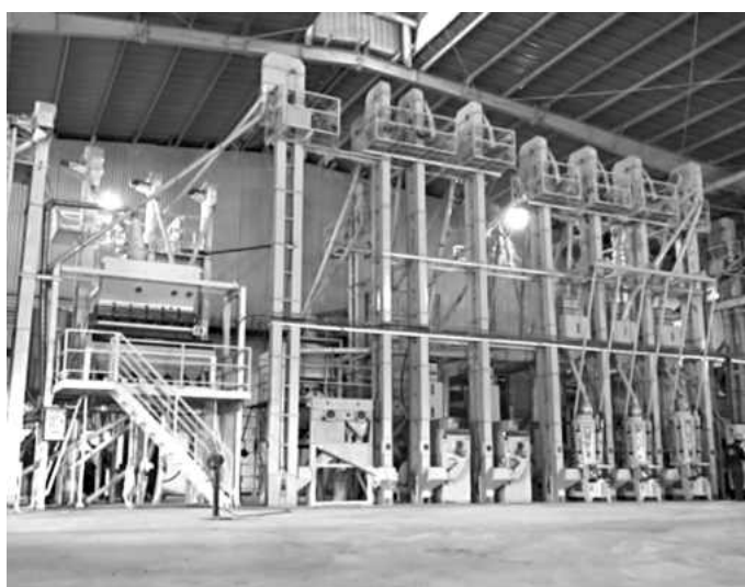
Nhà máy chế biến gạo hiện đại công suất 10 tấn/giờ của Tổng Công ty CP Vật tư Nông nghiệp Nghệ An
