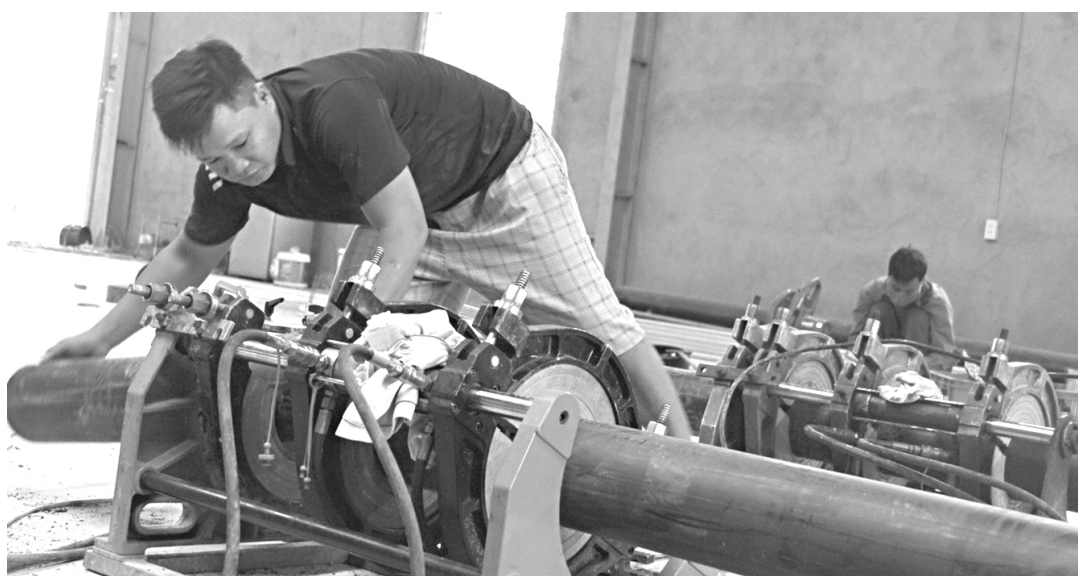
Công nhân đang lắp đặt khung lồng HDPE
