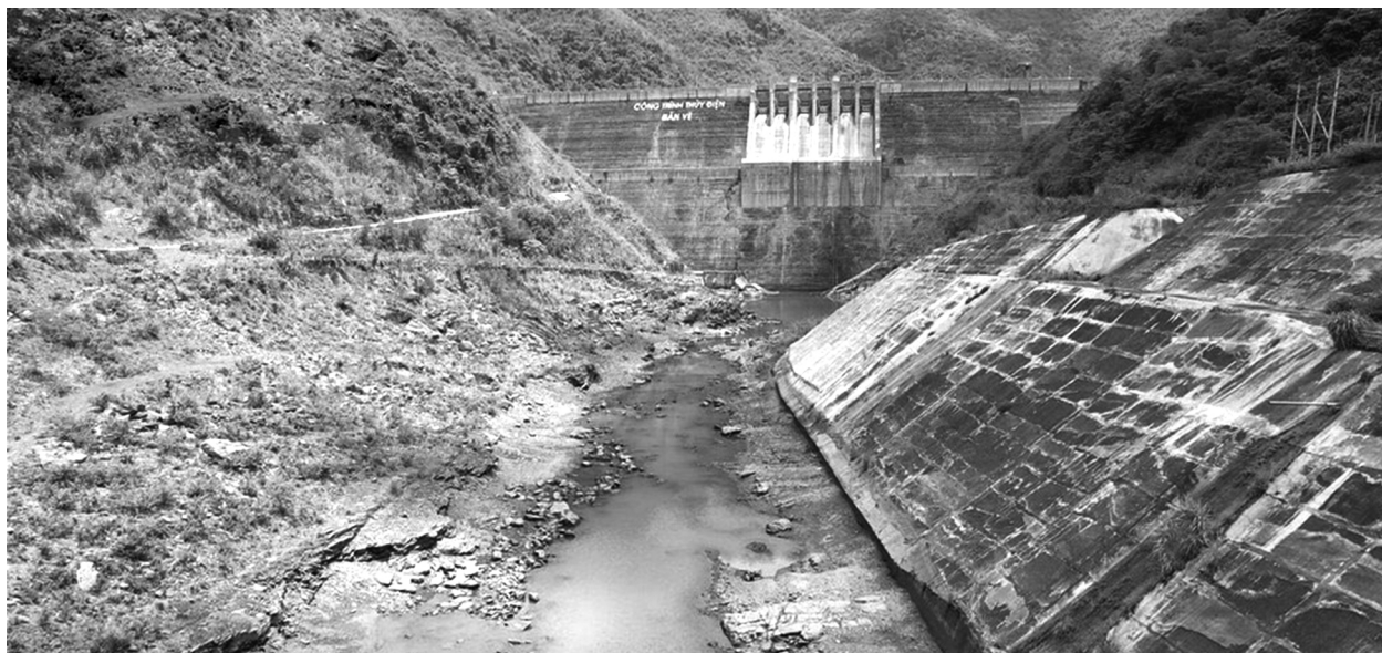
Mực nước hiện đạt thấp nghiêm trọng tại hồ Thủy điện Bản Vẽ
