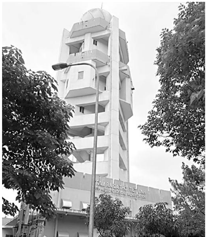
Hình 1: Trạm Ra đa thời tiết Vinh
